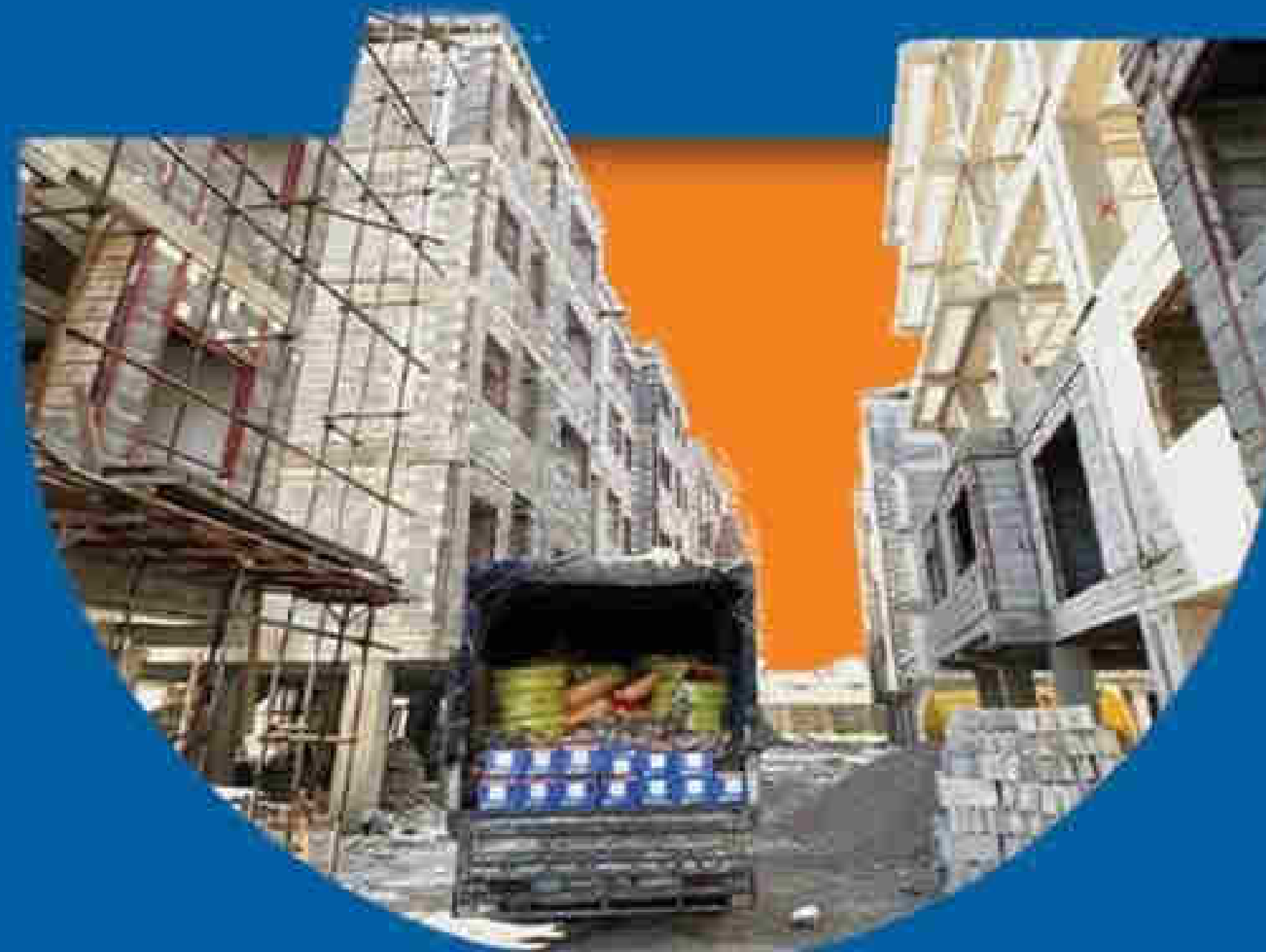
پروژه ۱۸۰ واحدی بهار
